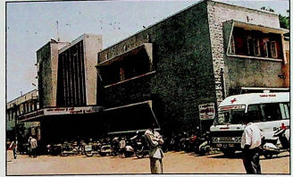
इन्दिरा गांधी चिकित्सालय का मुख्य भवन
